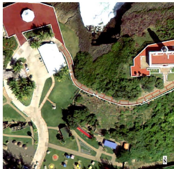
Imagen 39. Faro antes del huracán
