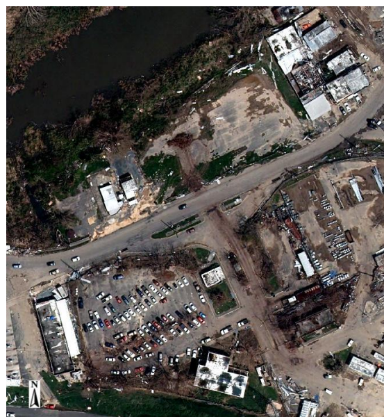
Imagen 36. Estructuras después del huracán
