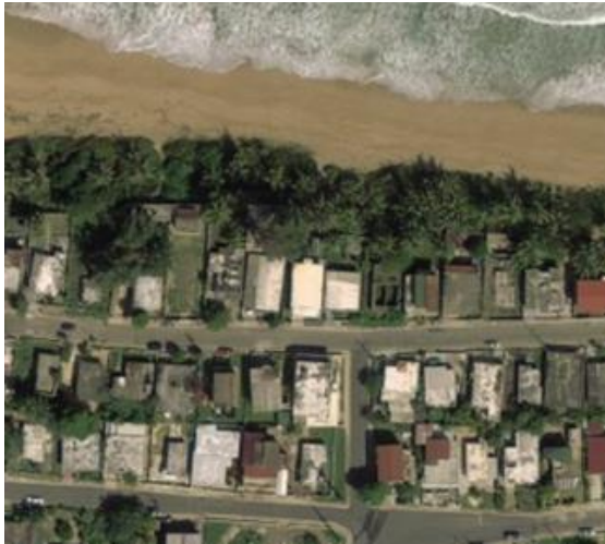
Imagen 41. Estructuras antes del huracán
